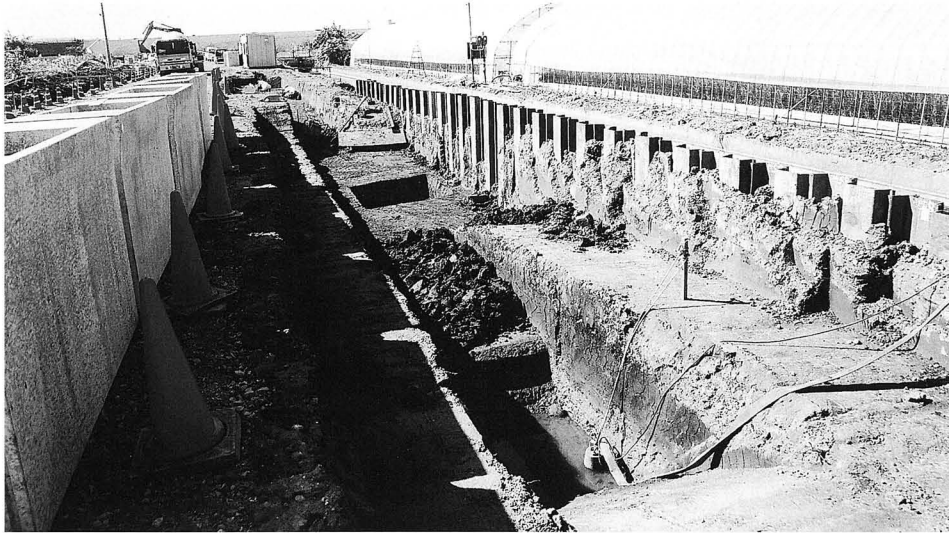
調査東区北側 調査状況 東より
