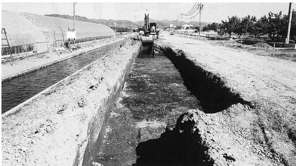
調査東区北側掘削状況 西方より
