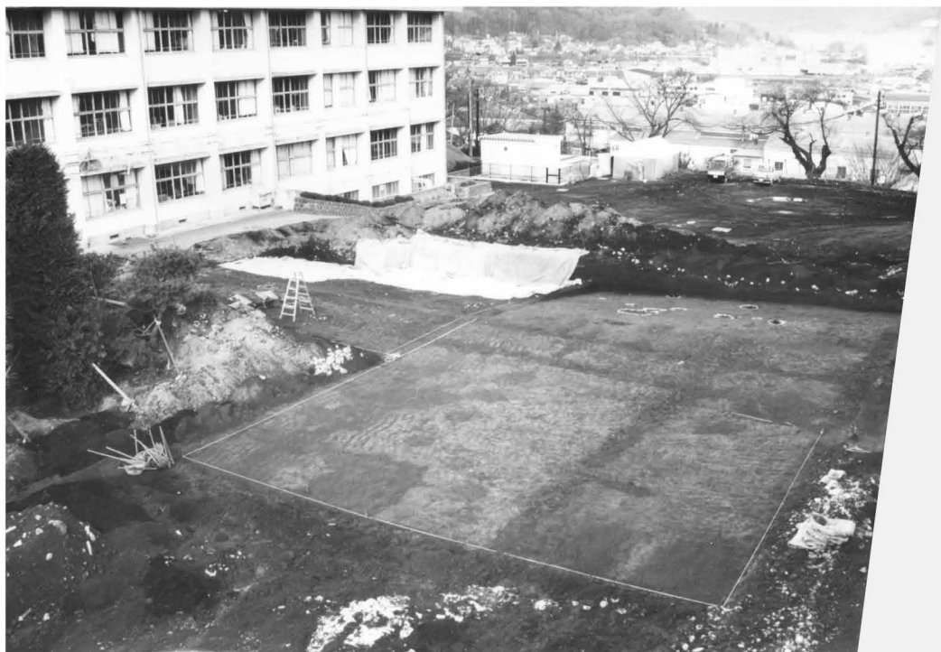
1. 第2次調査昇降口棟区全景
