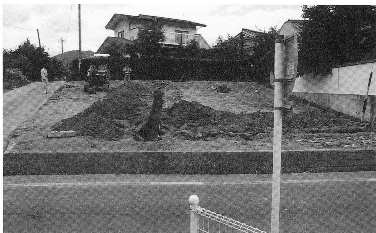
(2) 信濃国分寺跡 国分1, 203調査
