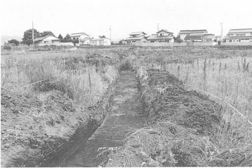
写真11 6-3号線(上久保田向)(北方より)
