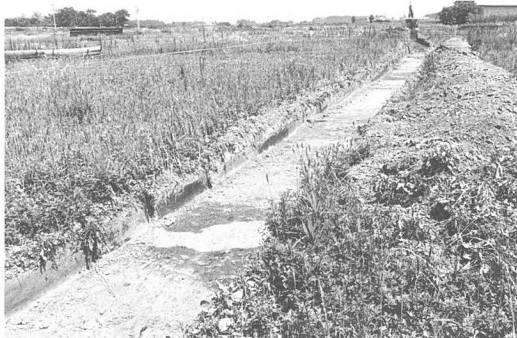
写真6 湖東線（大馬久保）（北西方より）
