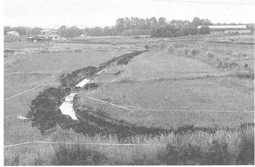
写真12 湖南線南側(南東より)
