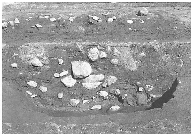
図6 礎石建物SB530の礎石据付掘形
