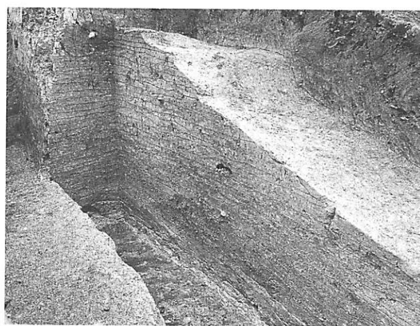
図59 塔基壇中の水平な版築 南区断ち割りの東壁
