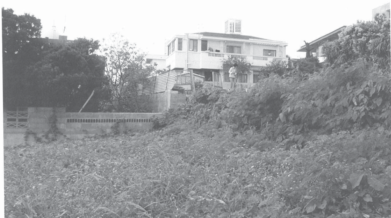
写真7. 掛保久防空壕遠景〔南より〕
