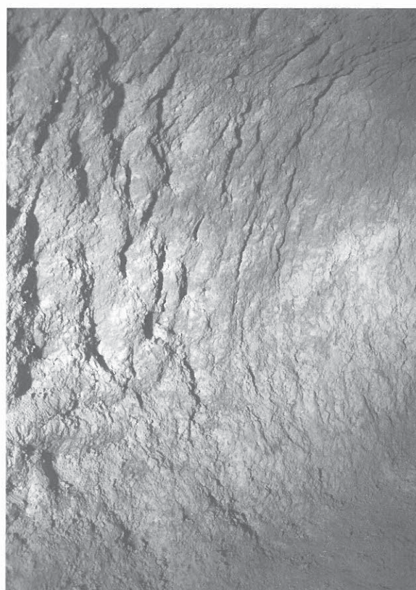
写真 17. 壁面掘削痕 [南西より]
