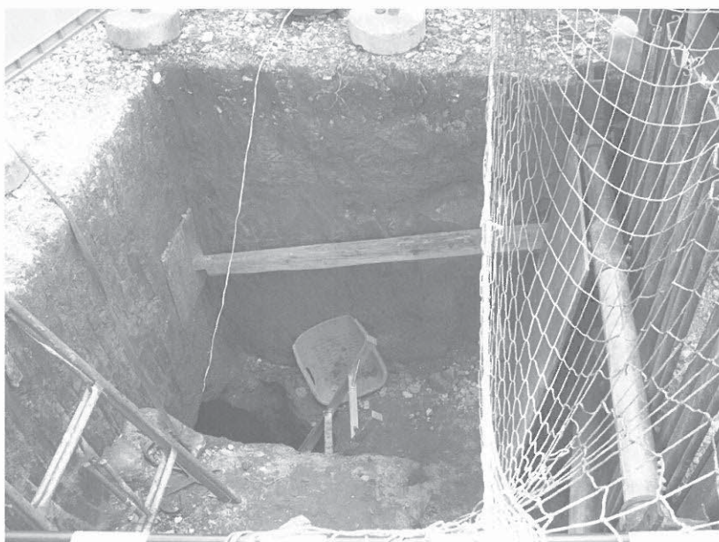
写真 9. 防空壕発見地点 [北東より]
