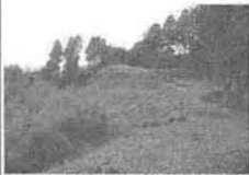
南側土塁跡西端部・全景（東から）
