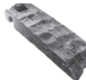
図246 端部の杭状加工とチョウナ痕跡 (7)
