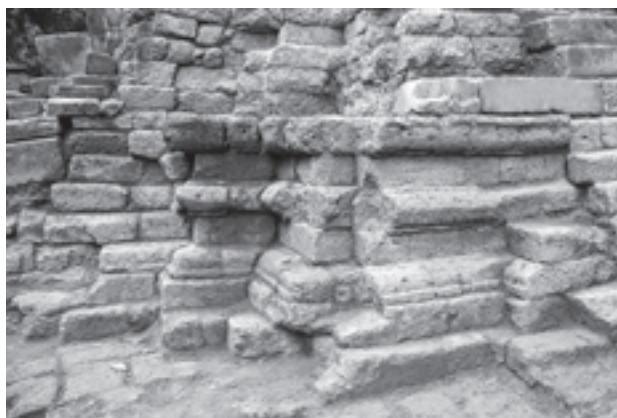
図24 ラテライト中成基壇張り出し部の欠き込み
