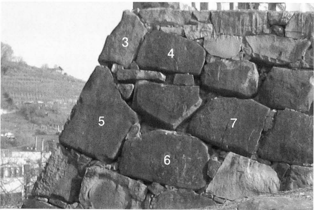
写真 13 洗浄前の状況
