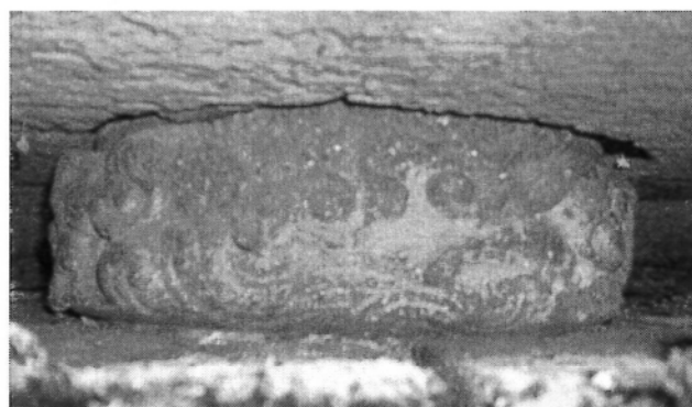
千光寺宝篋印塔 基礎支脚
