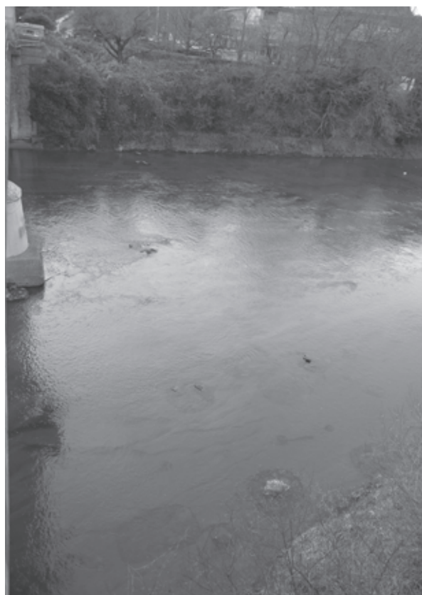
1. 現大橋北側の河床に並ぶ木橋時代の橋脚柱穴（東から）
