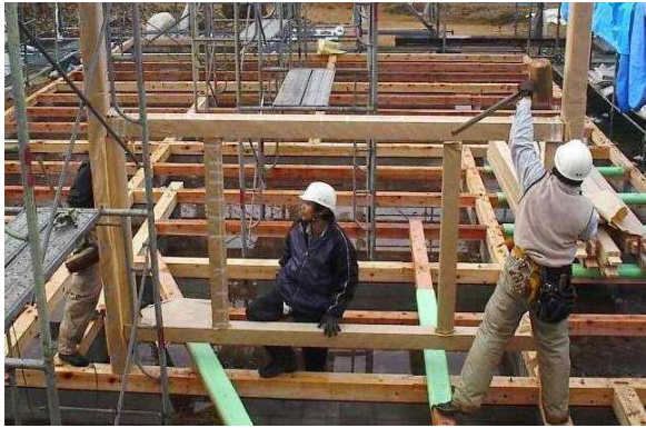
図 20-1 建築途中の様子
