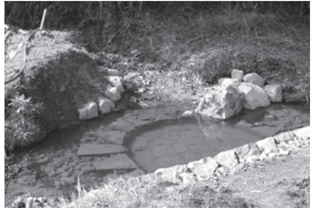
図26 白糸台地における水路合流部の土砂堆積対策 （冬場に魚類が利用する貴重な深みとなる）
