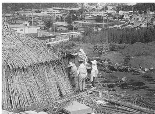
写真8 屋根・壁を葺く
