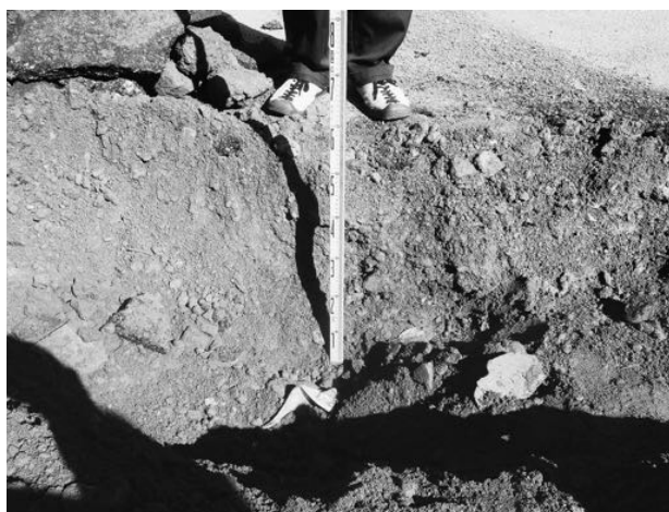
図 10 (南常三島) 囲障改修に伴う基礎取設
