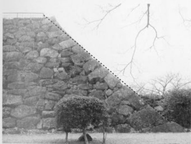
③天守台南東隅角部（南面）
