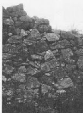
④天守台南西隅角部
