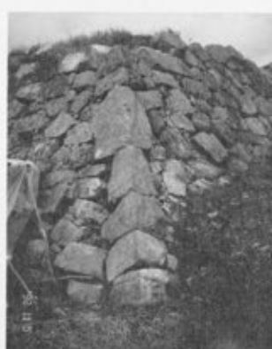
⑤本丸南門虎口隅角部
