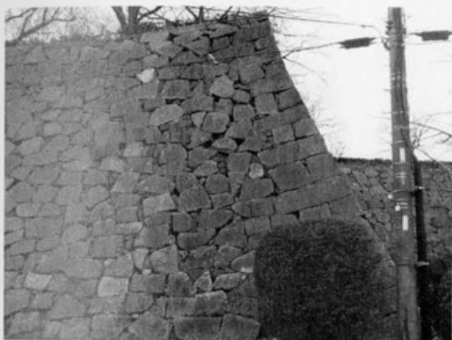
③二の丸松原櫓隅角部（北面）
