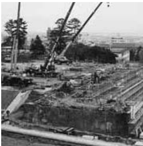
写真3 菱櫓・五十間長屋・橋爪門続櫓台の石垣解体調査風景
