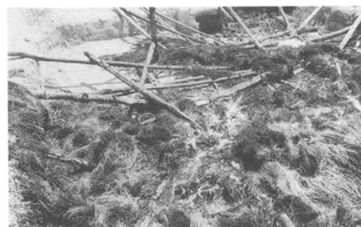
⑪ 鎮火後 柱が中央で折れている（北西より）
