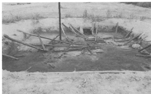
⑧ 葺き材（藁）撤去後の状況（西より）
