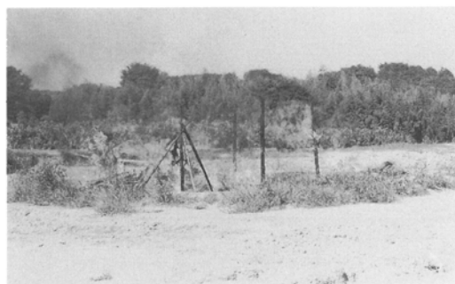
④ 2:30経過 築・桁・棟材落下後（東より）
