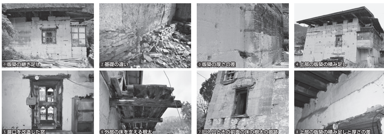
図12 改造変遷の様々な痕跡
