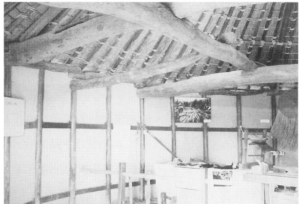
第15図 砂糖しめ小屋の小屋組み
