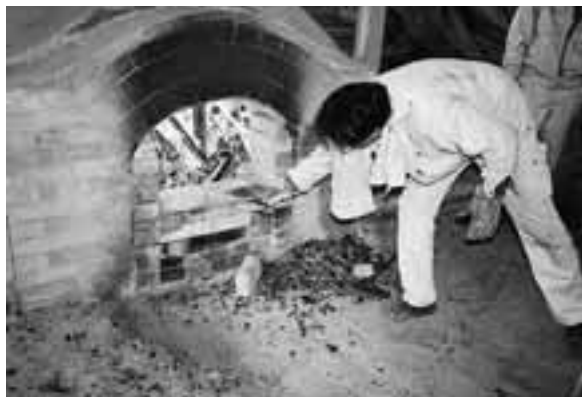
写真11 焚き口閉塞作業風景 1
