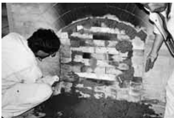
写真12 焚き口閉塞作業風景 2
