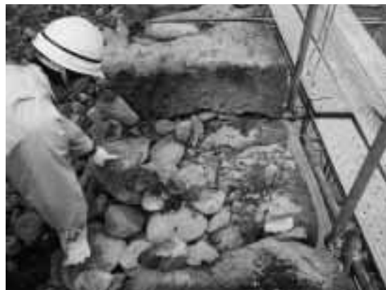
写真2 ジンザの石積み技法を調べる
