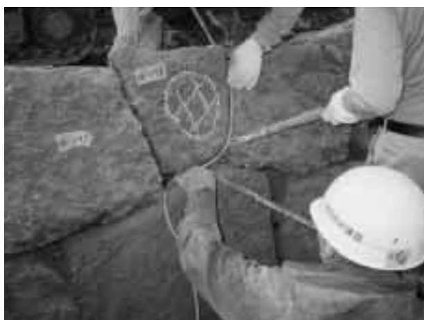
写真1 石垣の解体風景
