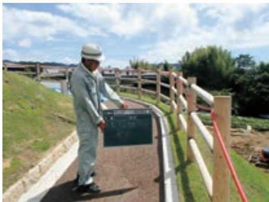
Fig.188 転落防止柵完成
