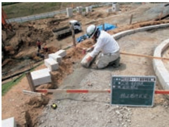
Fig.186 園路縁石設置状況
