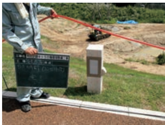
Fig.178 照明灯防水コンセント付
