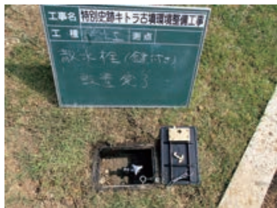
Fig.173 散水栓設置完了
