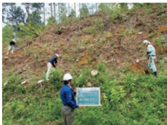
Fig.137 補植A施工状況
