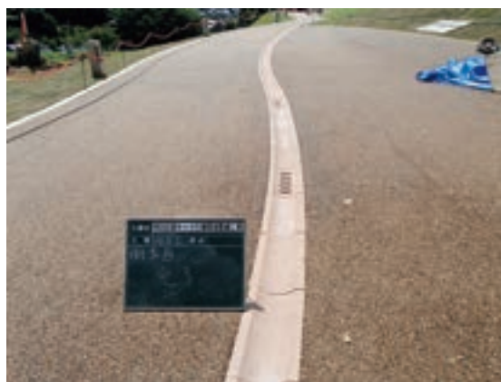
Fig.130 側溝B施工完了
