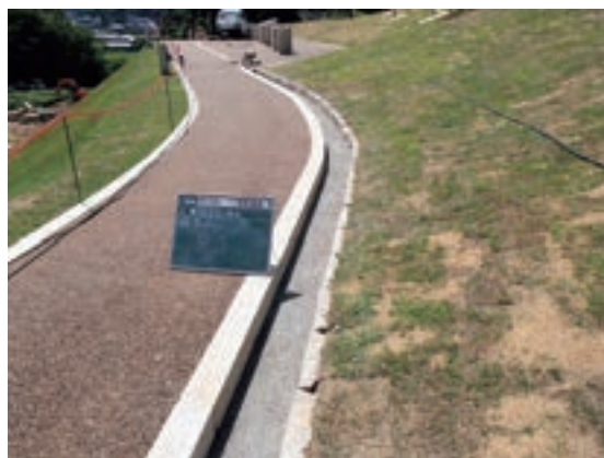
Fig.128 側溝A施工完了
