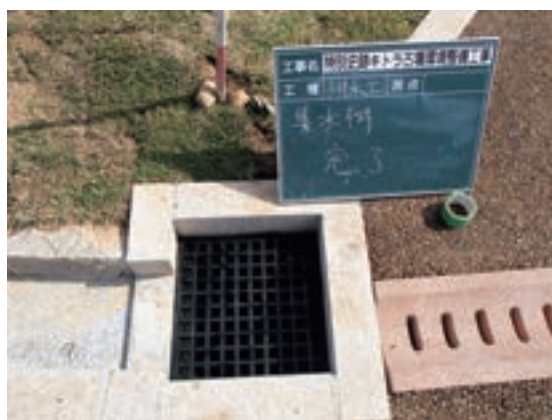
Fig.132 集水桝施工完了
