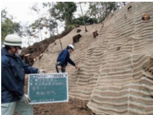
Fig.116 植生マット張り完了 平成27年4月
