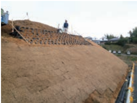
Fig.110 補強土壁表面の張芝（園路西斜面）
