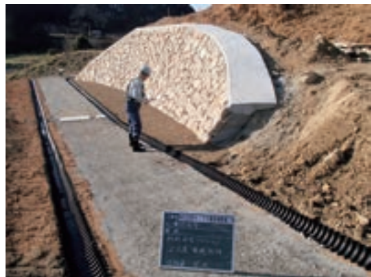
Fig.125 石積擁壁完了
