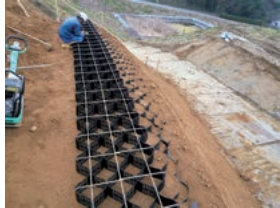
Fig.109 補強土壁施工状況（園路西斜面）②
