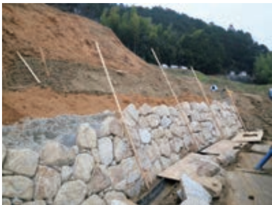
Fig.124 石積擁壁施工状況
