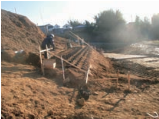
Fig.108 補強土壁施工状況（園路西斜面）①
