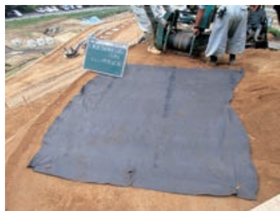
Fig.105 層圧管理材施工状況
