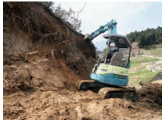
Fig.115 オーバーハング上部掘削
