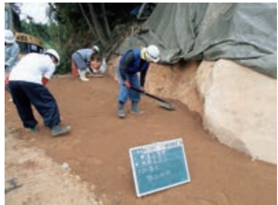
Fig.97 人力盛土施工
