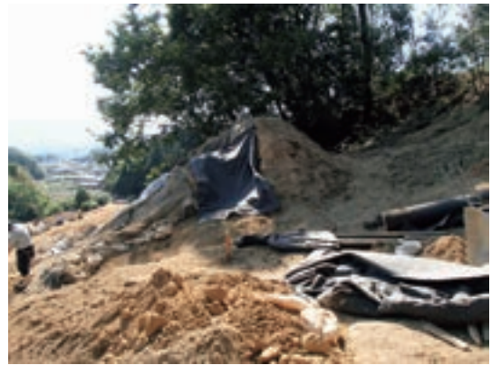
Fig.95 土のう・不織布撤去状況
