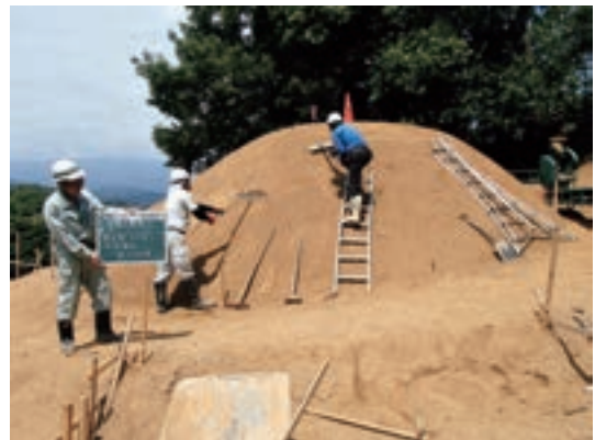
Fig.99 盛土整形作業
