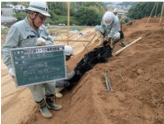
Fig.98 墳丘下段部テラセル設置状況
