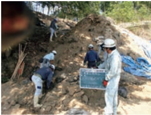
Fig.94 土のう撤去状況
