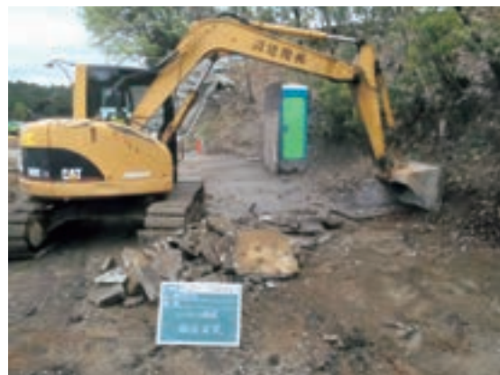
Fig.77 コンクリート舗装撤去状況
