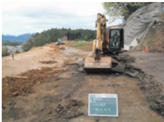
Fig.76 アスファルト舗装撤去状況
