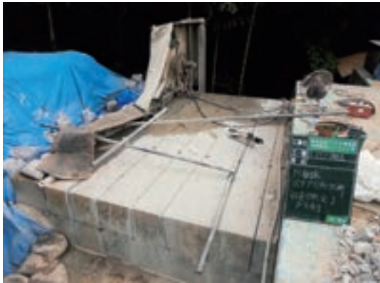
Fig.50 小前室PC躯体スラブの8分割切断
