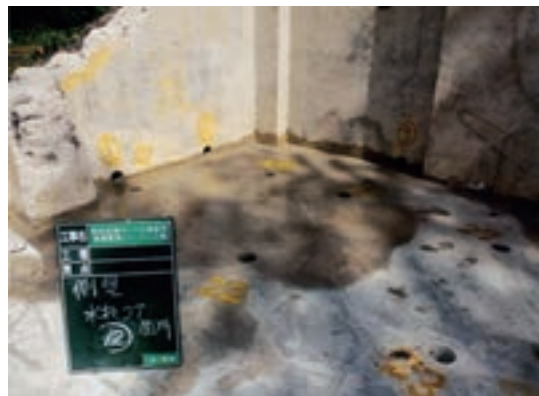
Fig.55 機械室側壁 水抜きコア削孔状況
