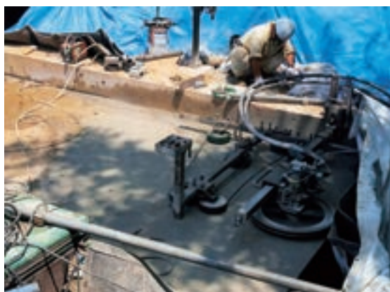
Fig.48 突起梁部分 ワイヤソーでの水平切断状況
