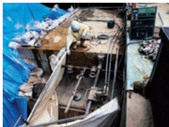
Fig.49 スラブ西側側壁 分離切断
