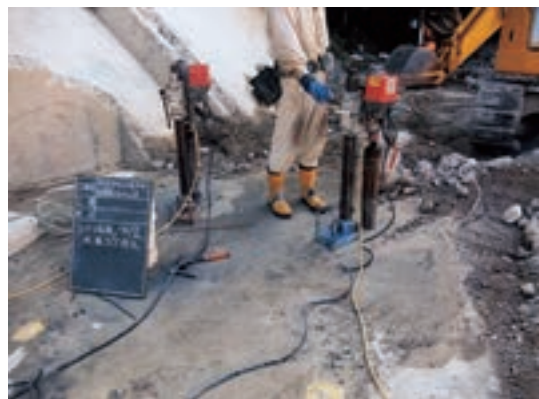
Fig.53 機械室床盤 水抜きコア削孔作業
