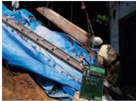
Fig.51 東側基礎吊り上げ撤去
