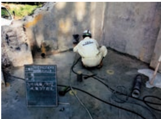
Fig.54 機械室側壁 水抜きコア削孔作業
