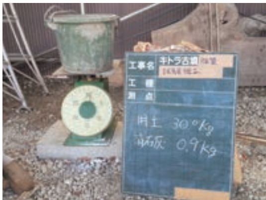
Fig.27 試験施工での材料の配合①
