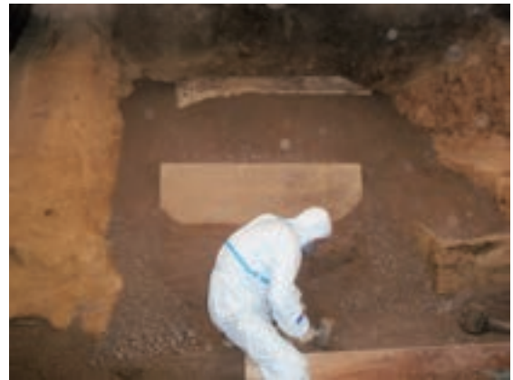
Fig.36 版築盛土作業
