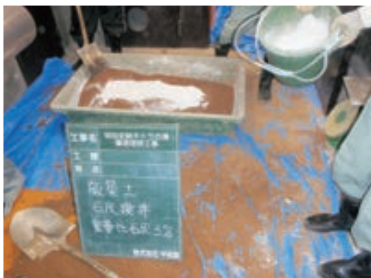
Fig.33 消石灰混合作業
