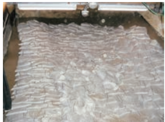
Fig.40 土のう養生の完了
