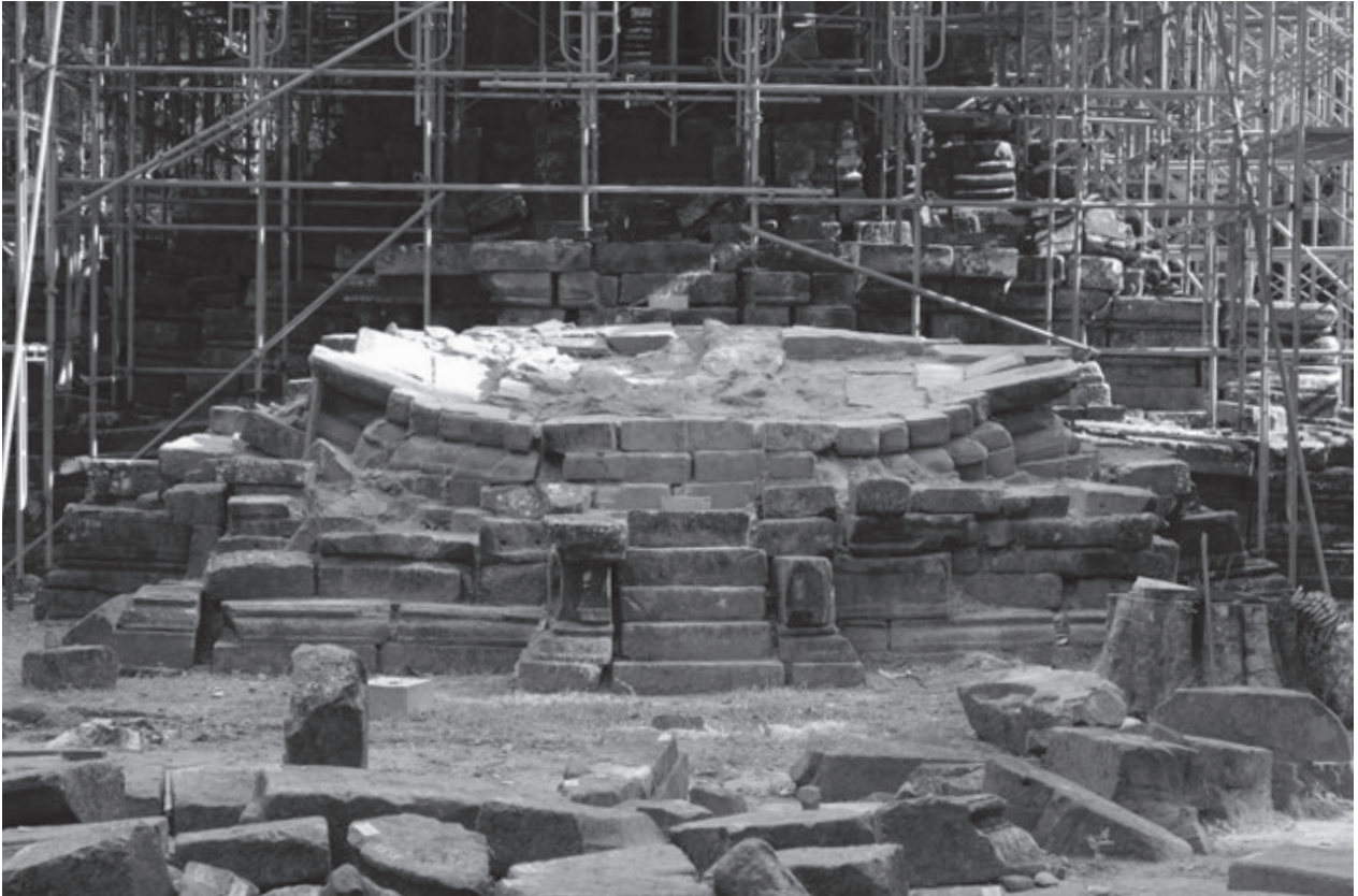
写真 -4 上成基壇上面の沈下
