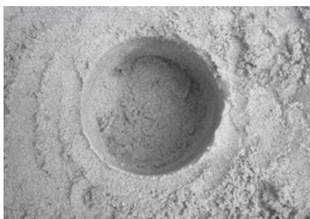
写真-8 下成基壇盛土の侵食状態
