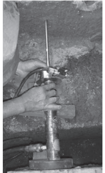
写真-27 養生後側壁部分の強度検査
