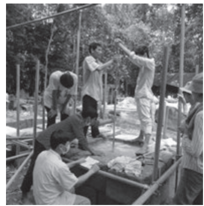
写真 -21 試験盛土完了直後の簡易貫入試験による品質検査
