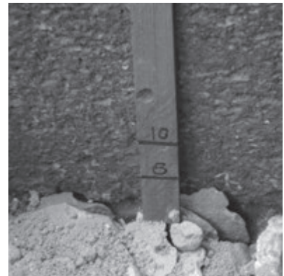
写真 -15 巻きだし厚さと締め固め厚さ
