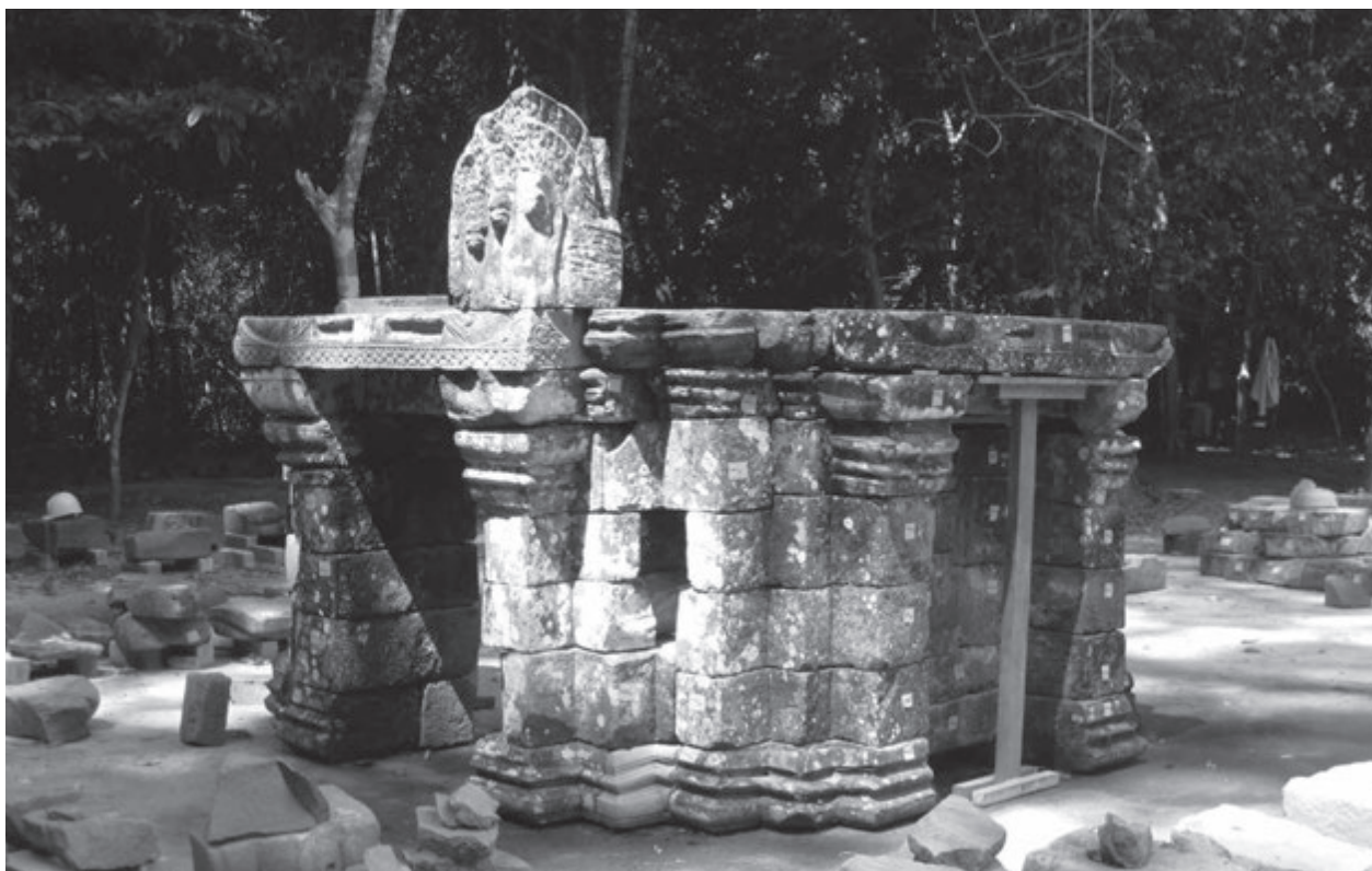
第73図 躯体部の仮組（北東から）
