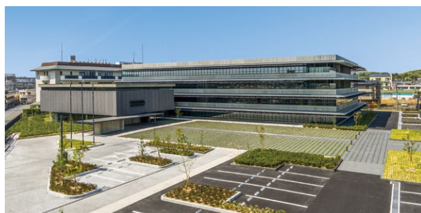
完成した新庁舎（南東から）
