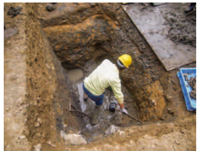
廃棄土坑掘り下げの様子 (東から)
