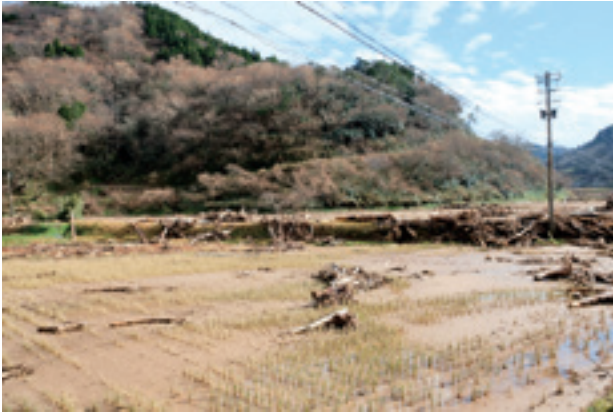
図79 イシガラの土手が流木の水田への流入を阻止
