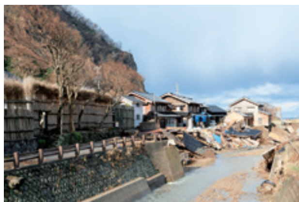
図74 西二又川の護岸崩落による間垣と家屋の流出
