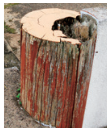
図64 柱頭部の過去の修繕箇所の劣化状況
