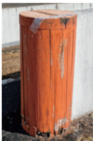
図65 柱頭部と地際部の過去の修繕
