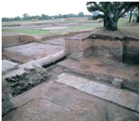
東面築地下の暗渠の底石（東南から）
