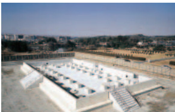
大極殿基壇全景（南東から）
