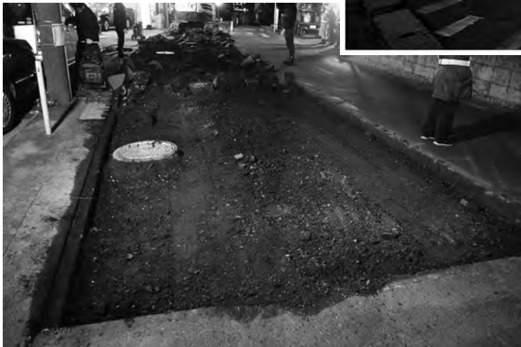
写真6 夜間工事立会い路盤材掘削状況
