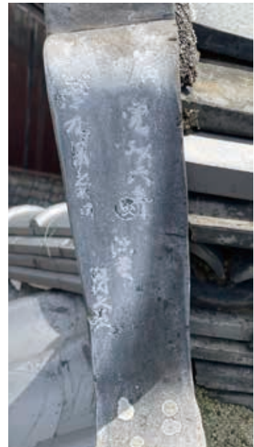
図6 玄関北端獅子口西面
