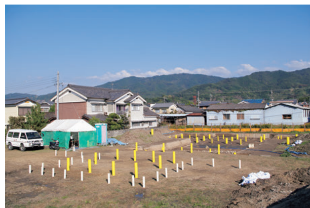
図8 現地説明会時の柱の表示（南西より）
