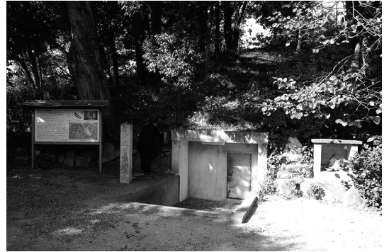
写真13 田代太田古墳の石室保護施設
