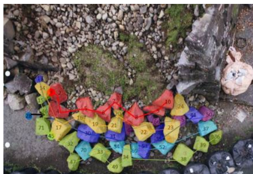
第3図 H99面石垣（北大手門周辺石垣）崩落解析図
