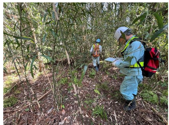
曲輪 A 南東側に亀裂
