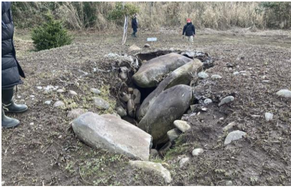
天井石が崩れて落下
