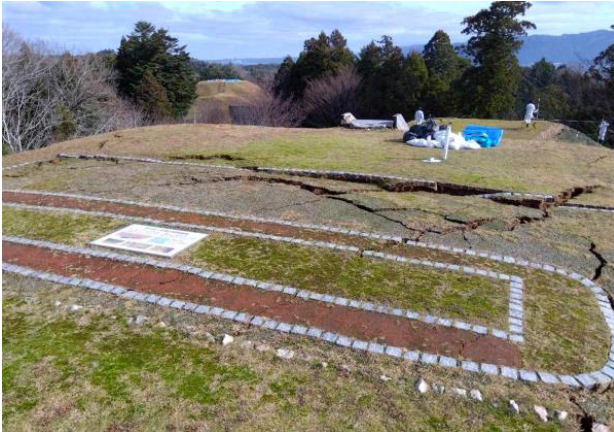
復元墳丘に無数の亀裂、葺石崩落
