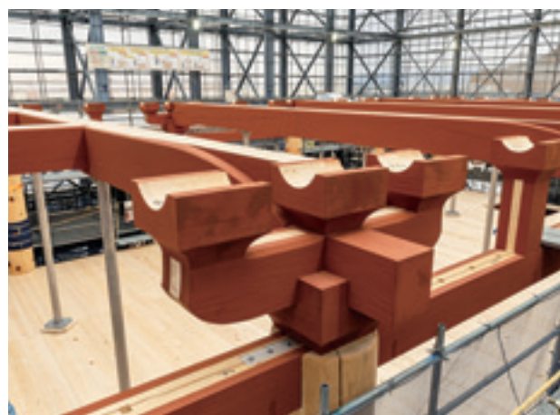
図60 東楼側柱上の組物（二二）（2024年1月31日撮影・北東から）
