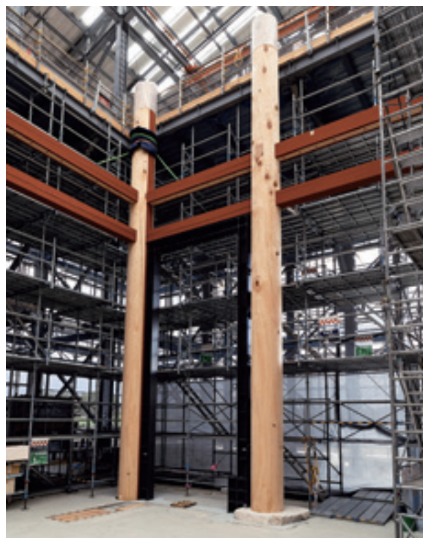
図59 東楼側柱の掘立柱（二一）と礎石建ちの柱（ハ一） （2023年9月7日撮影・南西から）
